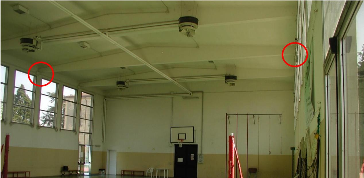
**PORZIONE A – Orditura del solaio di copertura con travi a doppia pendenza ed individuazione schematica delle carenze da rimuovere.**
