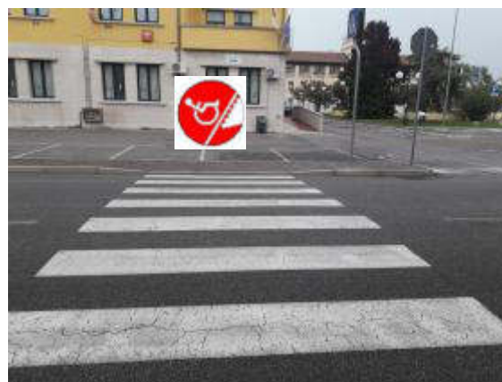
!2: Attraversamento in corrispondenza di un rialzo del cordolo
