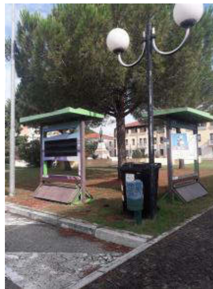
Doppio cordolo accostato con fuga 2cm e dislivello 1,5cm, rampa con pavimentazione sconnessa e degradata
