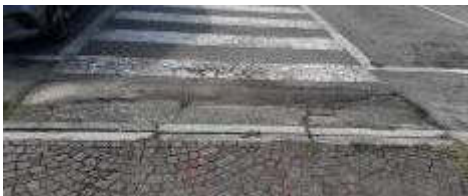
Doppio cordolo accostato con fuga 2cm e dislivello 1,5cm, rampa con pavimentazione sconnessa e degradata
