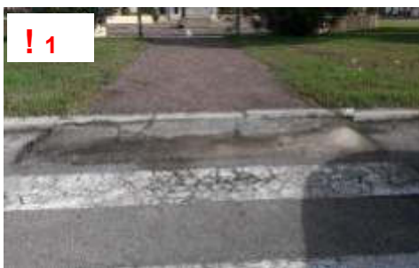
Doppio cordolo accostato con fuga 2cm e dislivello 1,5cm, rampa con pavimentazione sconnessa e degradata
