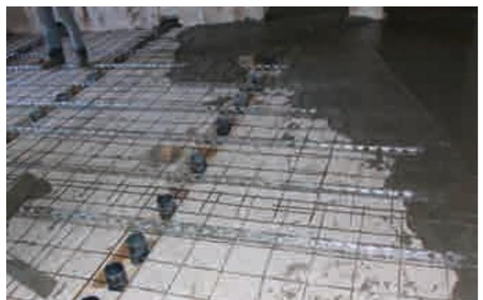
I solai in legno sono stati consolidati ed irrobustiti
