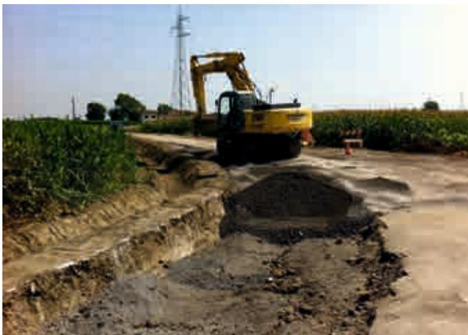
Per il sottofondo è stato impiegato del riciclato cementizio
