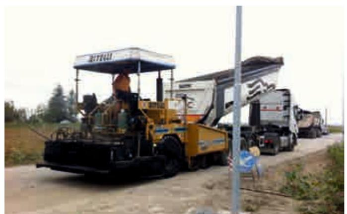
Lavori di asfaltatura con la posa del manto di binder
