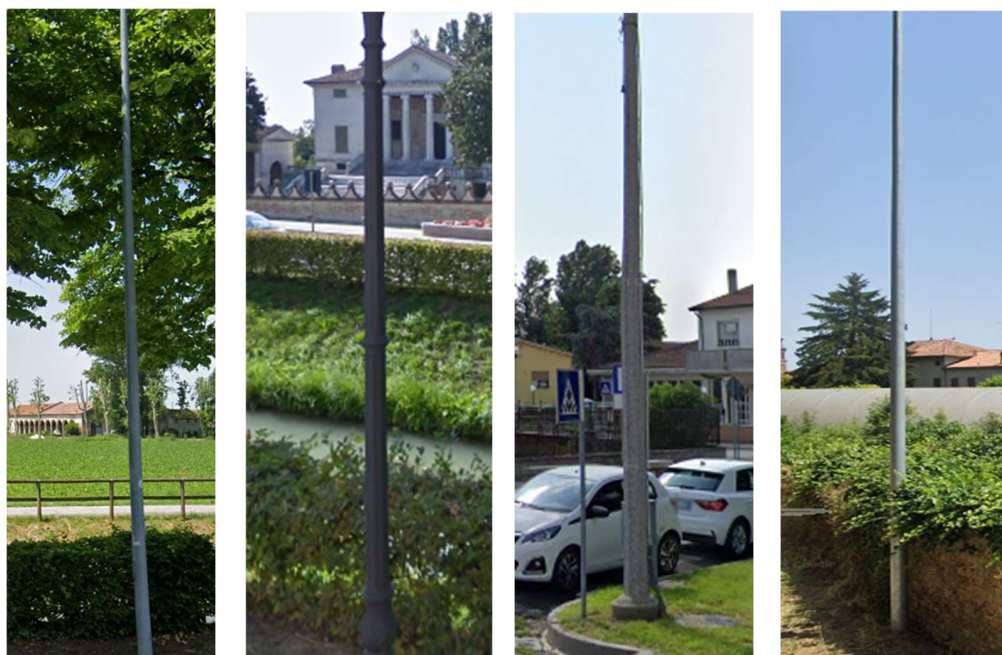
Figura 27 Esempi dello stato dei pali di Fratta Polesine
