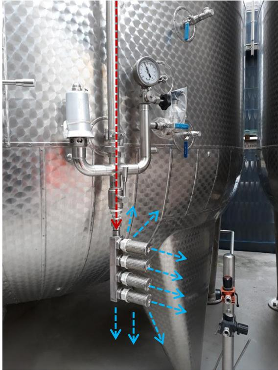
**Figura 6:** Esempio di silenziatore adottato
