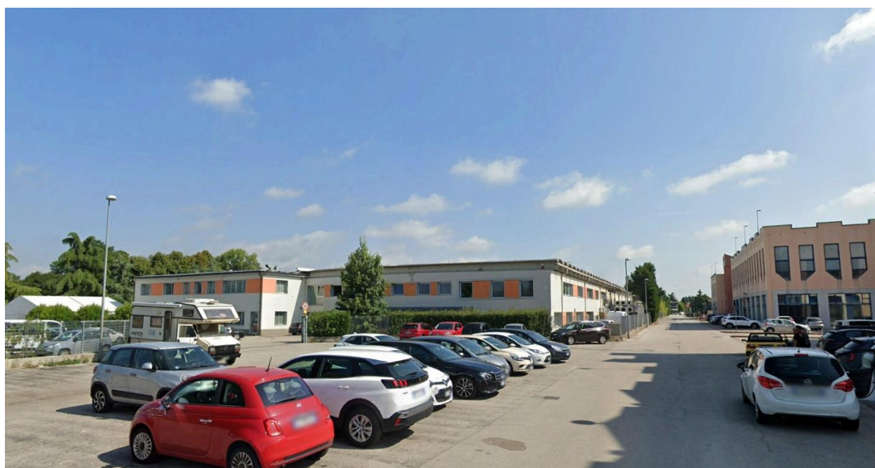
Vista dell'edificio sede della Società Euroristorazione e del parcheggio antistante
