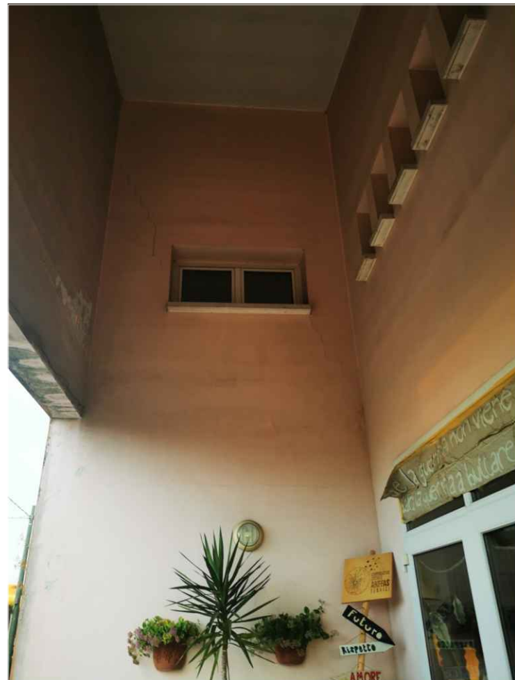
PORTICO A DOPPIA ALTEZZA DOVE INSTALLARE LA NUOVA PIATTAFORMA ELEVATRICE
