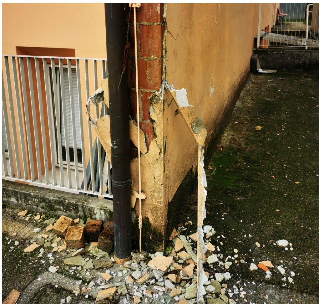
Dettaglio dell'angolo sud-ovest
