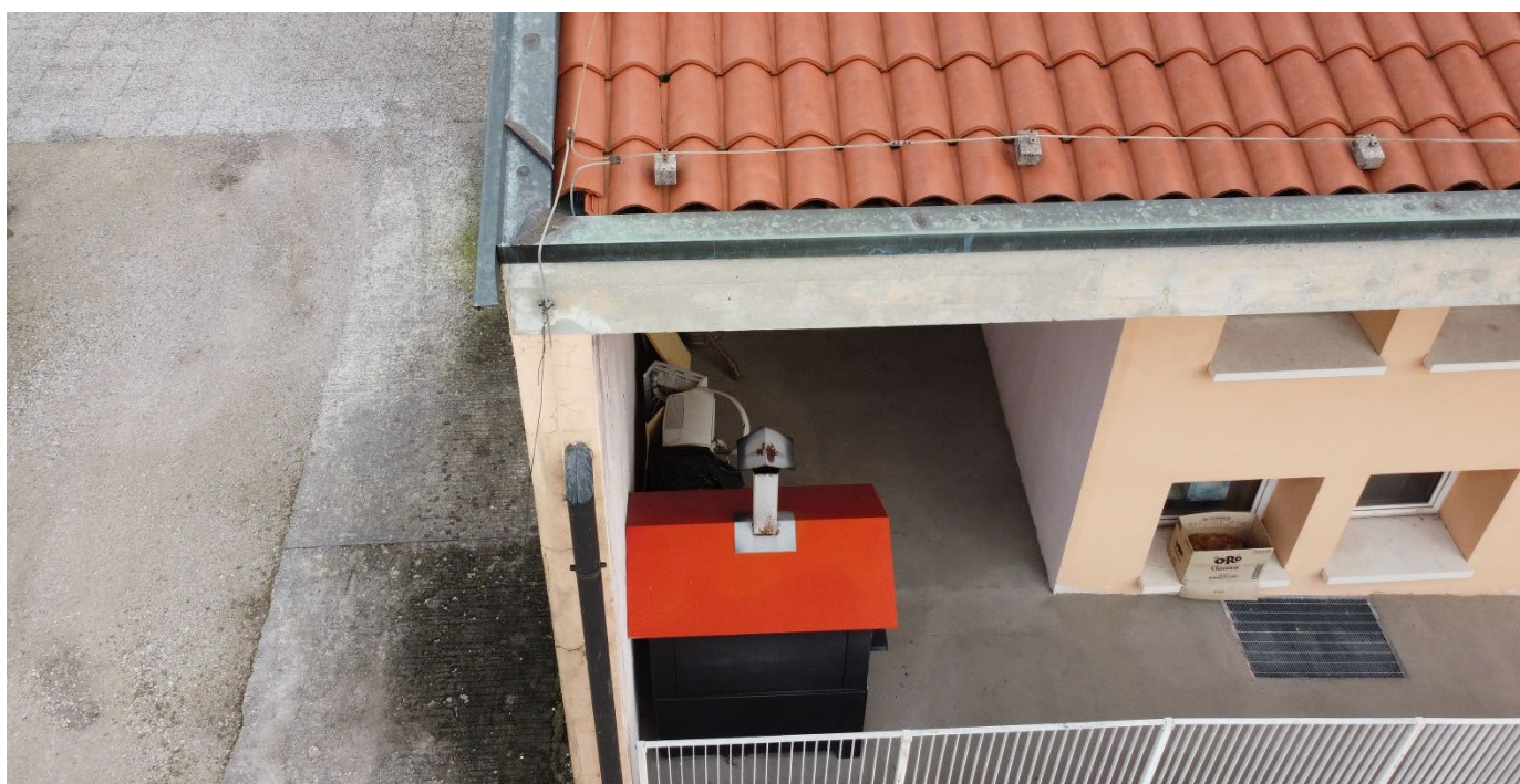
Dettaglio dello scarico delle acque bianche in copertura
