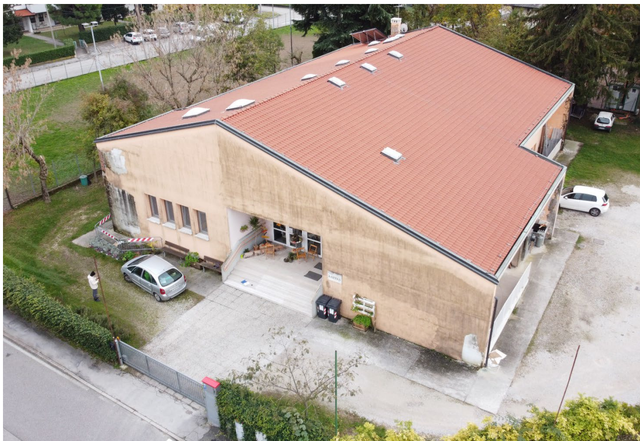
Vista aerea del prospetto nord
