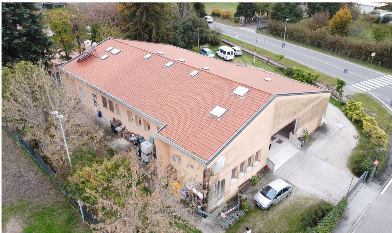
Vista aerea dei fronti nord ed est
