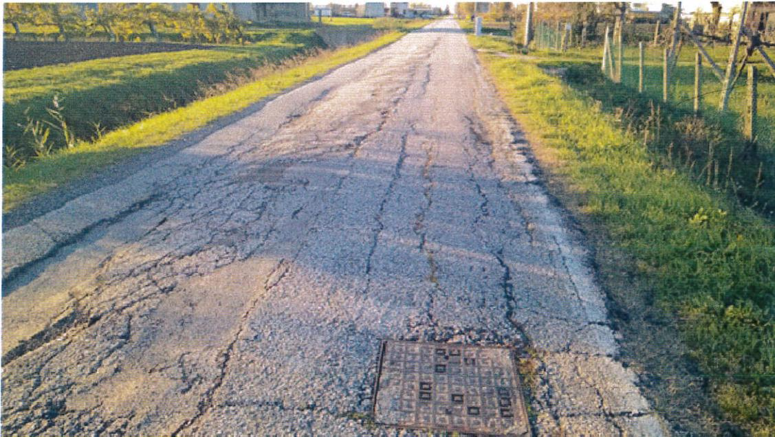
La deformazione del piano viabile, inoltre, non consente una adeguata regimazione delle acque meteoriche che, ristagnando pericolosamente sulla pavimentazione stradale, nel tempo, contribuiscono al continuo e progressivo deterioramento del manto stradale (vedasi foto 3 - pag.3) .
