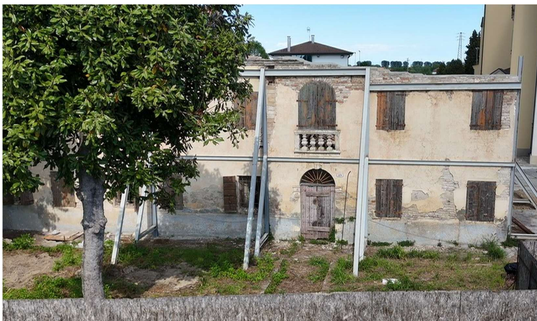
Figura 8. Vista Edificio successivamente alla messa in sicurezza
