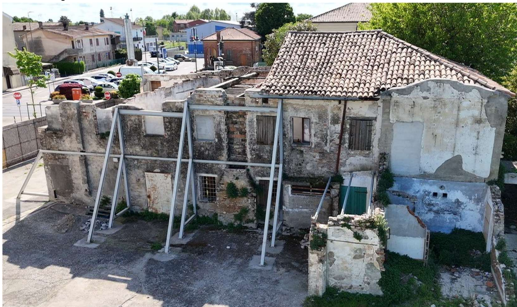
Figura 6. Vista Edificio successivamente alla messa in sicurezza
