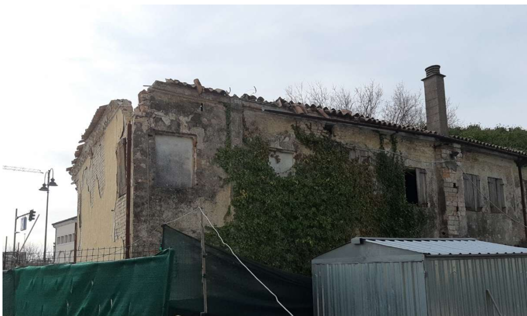
Figura 4. Vista edificio precedentemente alla messa in sicurezza
