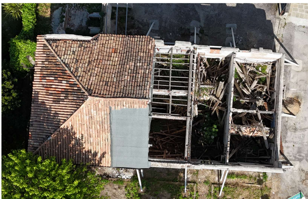
Figura 7. Vista Edificio successivamente alla messa in sicurezza
