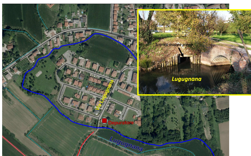
Scarico troppo pieno presso depuratore
