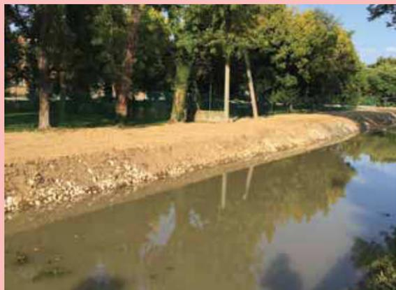
Le dimensioni dell'argine si erano ridotte a causa del flusso dell'acqua pertanto è stato necessario intervenire per ripristinare, attraverso la posa di roccia, le sponde.
