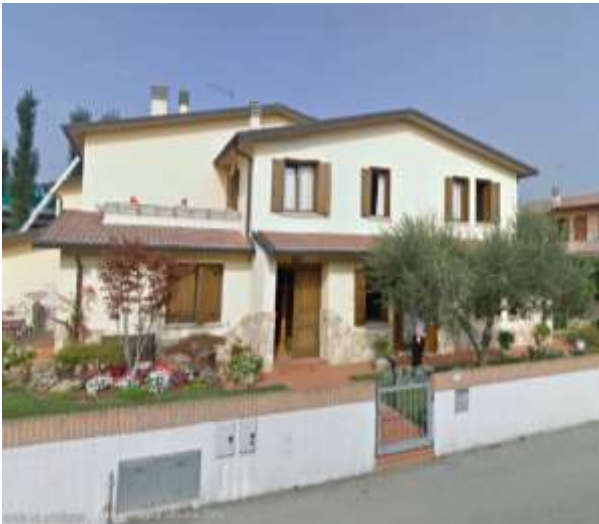
Figura 28. Sopra, alcuni esempi di edifici in Zona D
