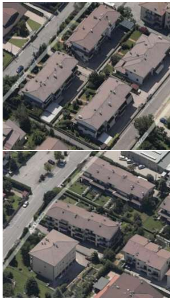
Figura 26. Sopra, due immagini di edifici in Zona D
