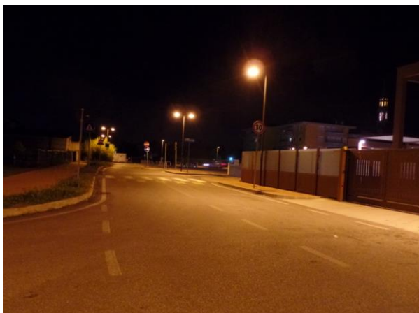
Illuminazione sodio alta pressione
